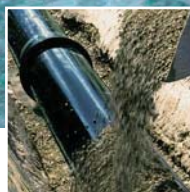
Schnell und günstig verlegen
