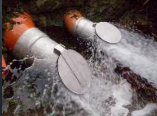
„Froschklappe“ bei der Überlauf-Entleerung des Behälters und bei der Oberflächendrainage der Quelle nicht vergessen
