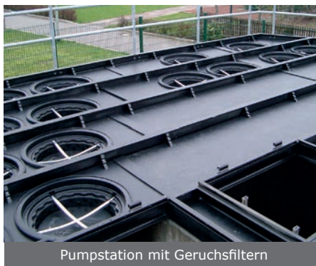
Aktive Entlüftung eines Speicherbeckens
